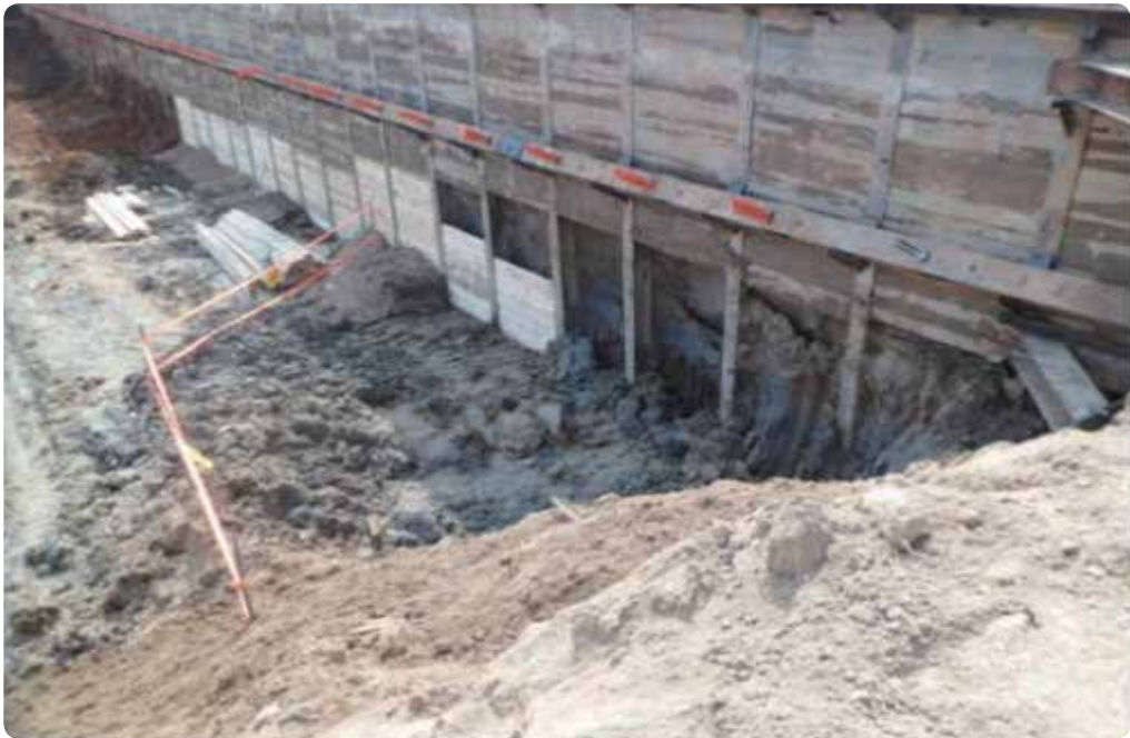
[사진 1] 재해발생 장소 전경
