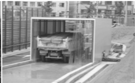
세륜장 방음터널 설치
