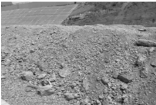
토사내 폐콘크리트 혼합 방치
