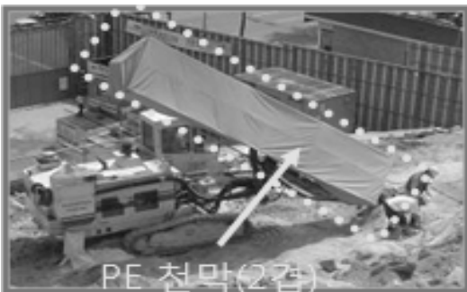
천공기 방음덮개 설치
