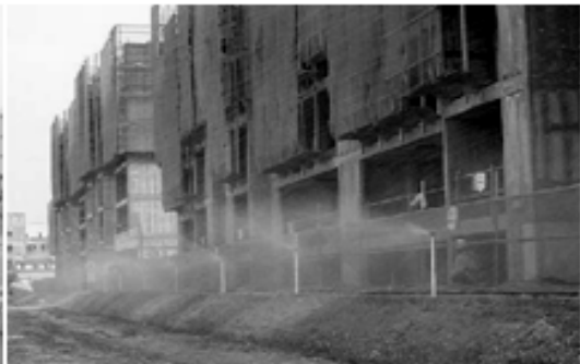
단지내 타이머스프링쿨러 설치
