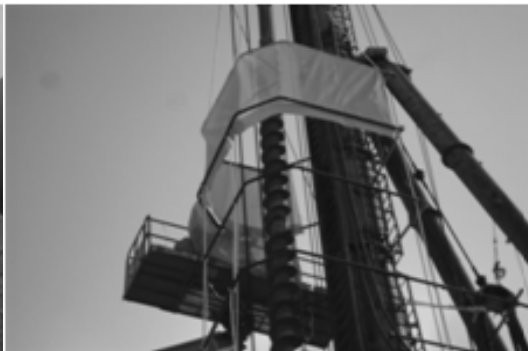
항타기 주름관 방진시설 설치
