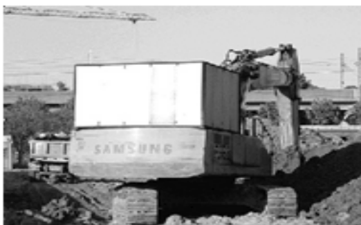
굴삭기 차음박스 설치
