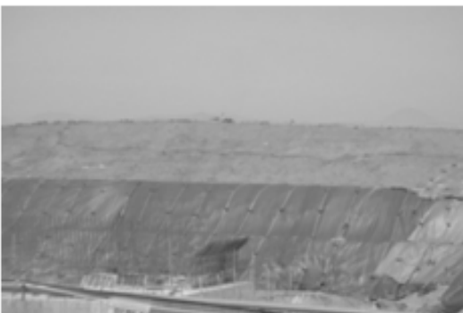
성토부 방진덮개 설치
