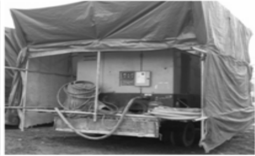
컴프레샤 방음커버 설치
