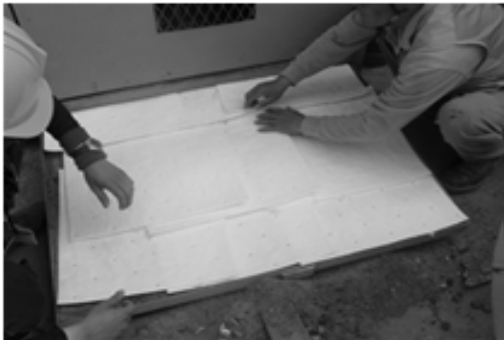
유류저장소 누유방지 흡착포 설치
