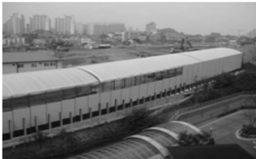
현장 진입로 방음돔 설치
