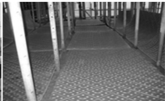
형틀 해체시 바닥흡음재 설치
