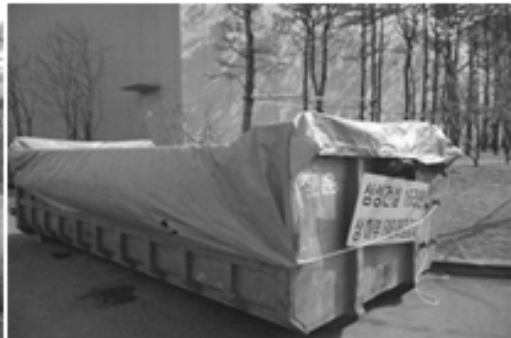
암물박스침출수 방지 덮개 설치
