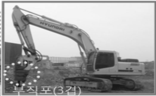
브레이커3겹 방음덮개 설치
