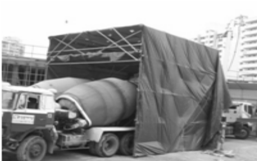
펌프카 방음커버 설치
